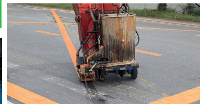
Nettoyage de matériels de dépose de peintures techniques, telles que peintures routières
